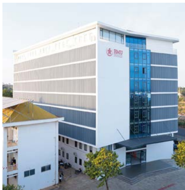
Năm 2025, Nhà trường hoàn thiện và đưa vào sử dụng tòa nhà 9 tầng, bao gồm Trung tâm Mô phỏng Y khoa và các phòng thực hành hiện đại.
