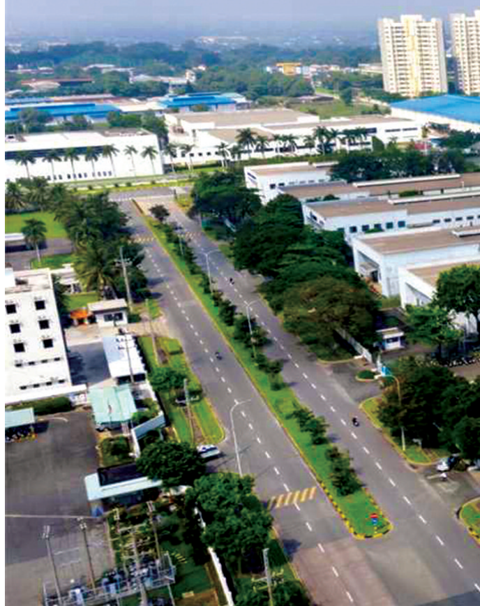
Khu công nghiệp VISIP, Bình Dương
