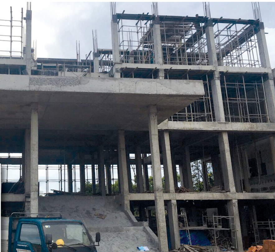
Thi công trụ sở Công An thị xã Quảng Trị – tỉnh Quảng Trị – Quy mô 560m2
