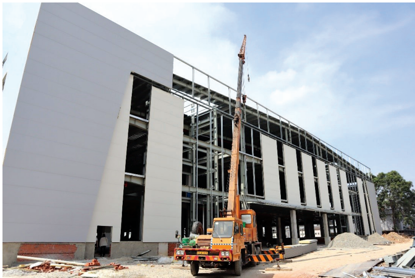
Một dự án tại TP.HCM đang được lắp dựng bằng Panel Phương Nam
