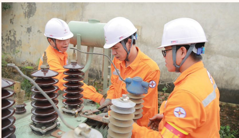
Công ty Điện lực Phú Thọ đã ứng dụng công nghệ sửa chữa điện Hotline (sửa chữa điện nóng) không cần cắt điện, giúp hạn chế thời gian cắt điện và nâng cao sự hài lòng của khách hàng.
