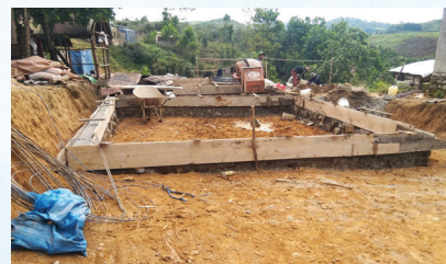
Căn nhà của gia đình ông K'Tàng (xã Đắk Plao, huyện Đắk Glong) được Công ty Thủy điện Đồng Nai hỗ trợ kinh phí khởi công xây dựng.
