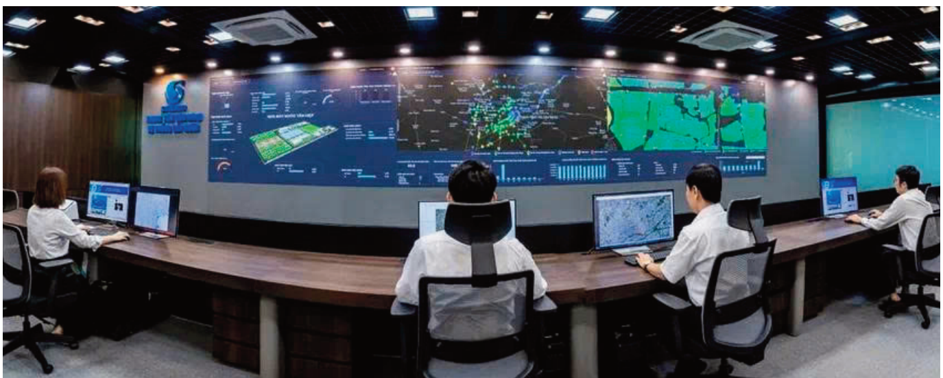
Trung tâm vận hành hệ thống Cấp nước SAWACO.
